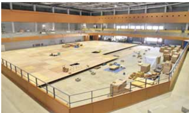
▲新更埴体育館のアリーナ工事 2月5日撮影
