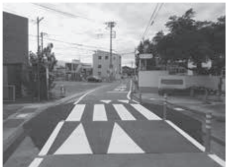
▲山梨県昭和町に設置された可搬式ハンプによるスムーズ横断歩道
