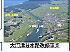
大河津分水路改修事業
