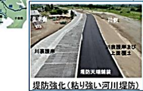
堤防強化（粘り強い河川堤防）
