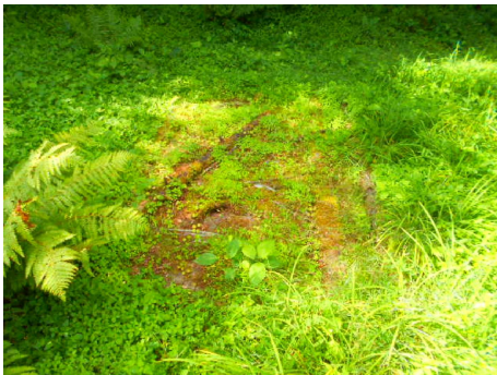
⑭雑排水浄化槽周り
