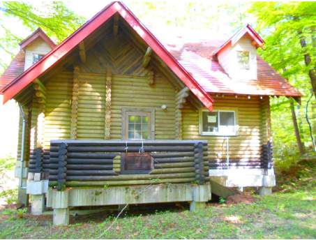
④キャビンA棟外部
