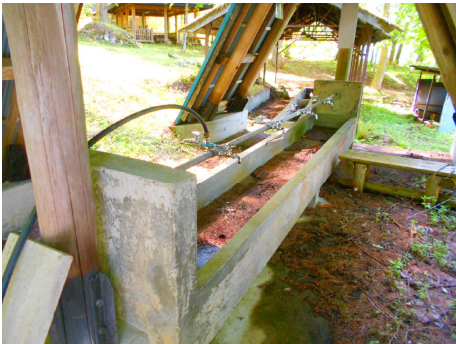
⑱水飲場内部
