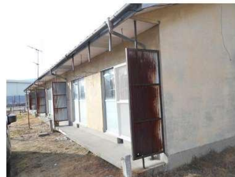
④80～83号棟南東より
