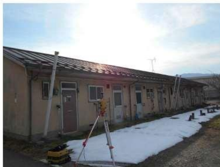
③80～83号棟北東より
