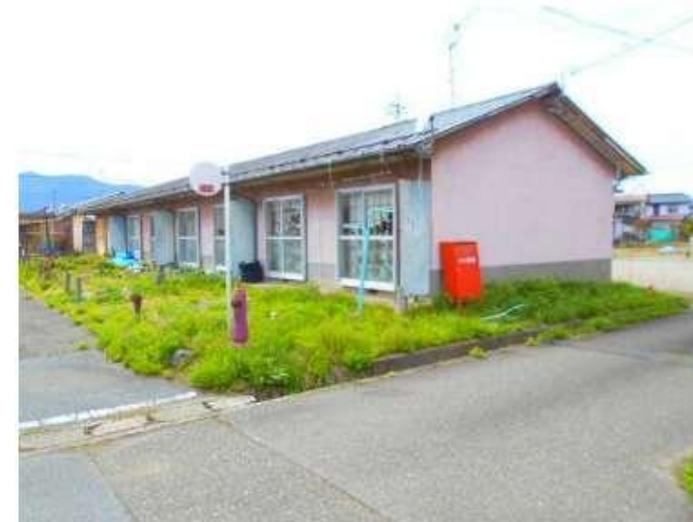
②30～33号棟南東より
