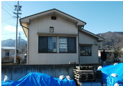
②東側より
