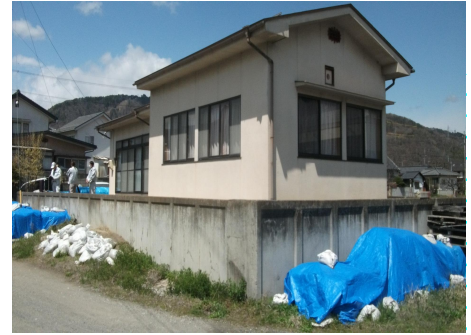
⑥外周L型擁壁廻り2
