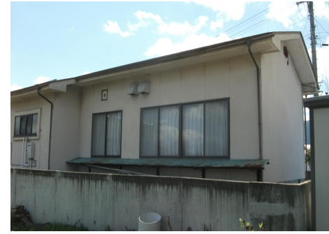
⑤外周L型擁壁廻り1
