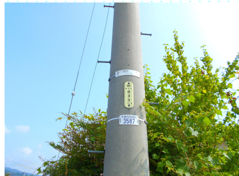
⑩建物付近電柱
