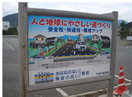
市が実施した透水性舗装（更埴体育館前の歩道）
