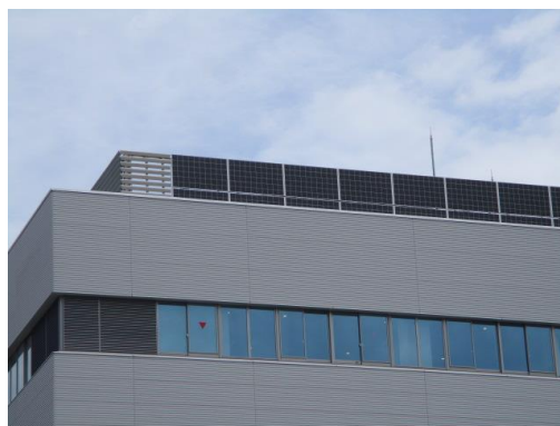
▲市役所屋上の太陽光発電パネル
