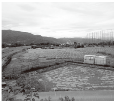
▲大型土嚢で霞堤からの流入をくい止める
