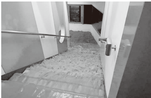
▲あんずホールのインナーコリドーから地下室へ流れ込む水の様子（令和元年10月災害時）
