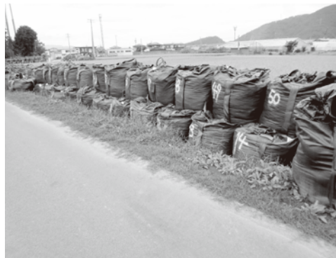
▲地域を守る大型土のう工事（中・新田地区）
