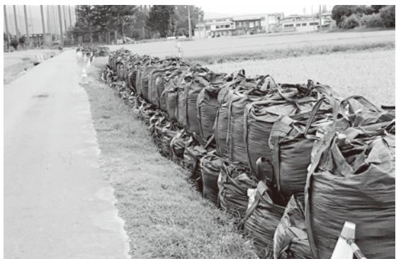
▲霞堤の大型土のう（中・新田地区）
