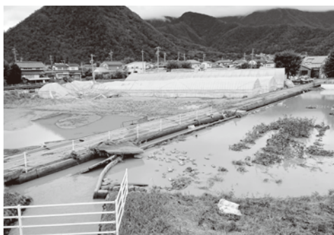
▲力石地区では東日本台風で住宅や農業用ビニールハウスに大きな被害が発生した
