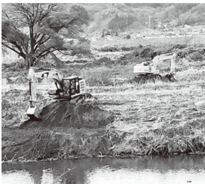
▲長野自動車道下千曲川河道掘削
