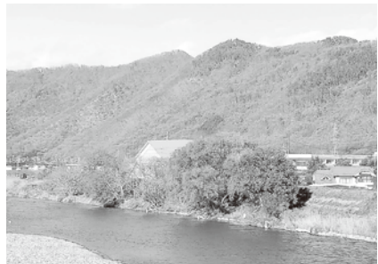
▲6月法面崩落があった暫定堤防は重要水防箇所に指定 (写真は、大正橋から戸上中学間)
