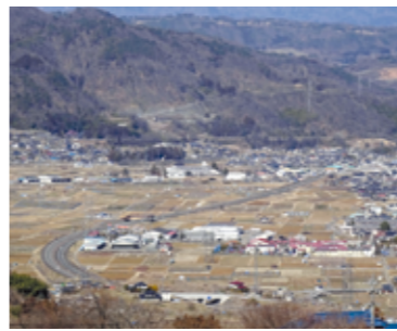
国交省が千曲市で唯一指定する「緊急避難道路高架区間」八幡の18号バイパス一帯
