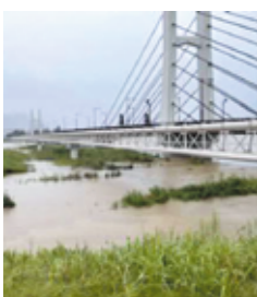
2021、8、15 大雨による千曲川増水 【千曲橋】
