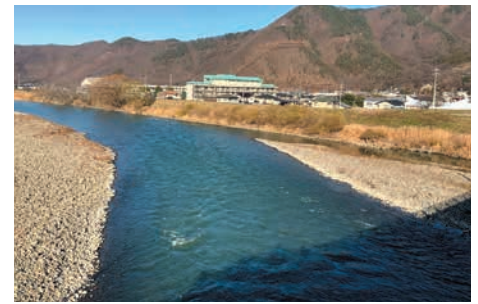
令和3年6月、大雨で土砂崩れのあった堤防道路（大正橋から戸上中の間） 堤防法面が基準に満たない暫定堤防及び重要水防箇所（令和4年12月撮影）
