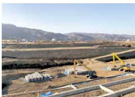
杭瀬下地区 災害復旧護岸工事現場
