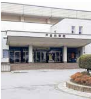
改修が予定されている戸倉体育館
