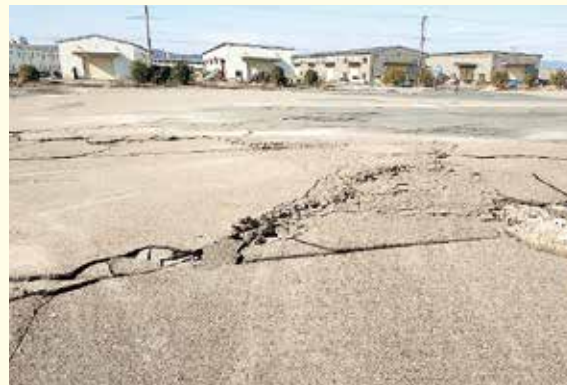
射水市 道路液状化による被害 (1月5日撮影)
