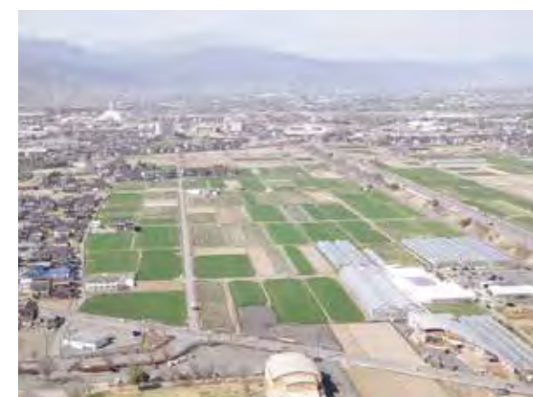
（仮称）屋代スマートインターチェンジ建設予定地域
