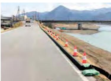
大正橋下流右岸道路面の雨水対策用アスカーブ(アスファルト製縁石)
