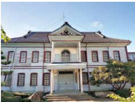
屋代小学校旧本館
