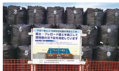
市道一重山2号線軟弱地盤対策盛土工事
