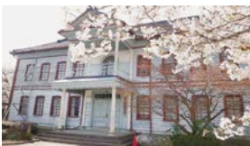
屋代小学校旧本館耐震改修工事に1億8千万円計上(令和7年度、8年度)
