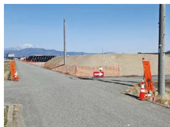
工事が始まった一重山2号線
