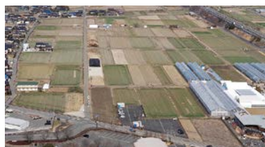
屋代地区 SIC 周辺の整備が進む (市道一重山2号線ほか)
