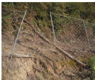
倒木によってネットの一部を押し下げられた事例
