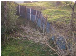
傾斜地で2段に重ねられたトタン板
