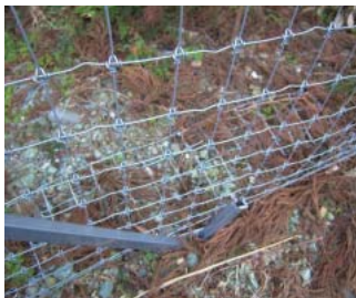
獣害防護柵用の金網（接地面が外に折り返されている）
