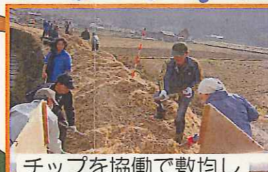
チップを協働で敷均し
