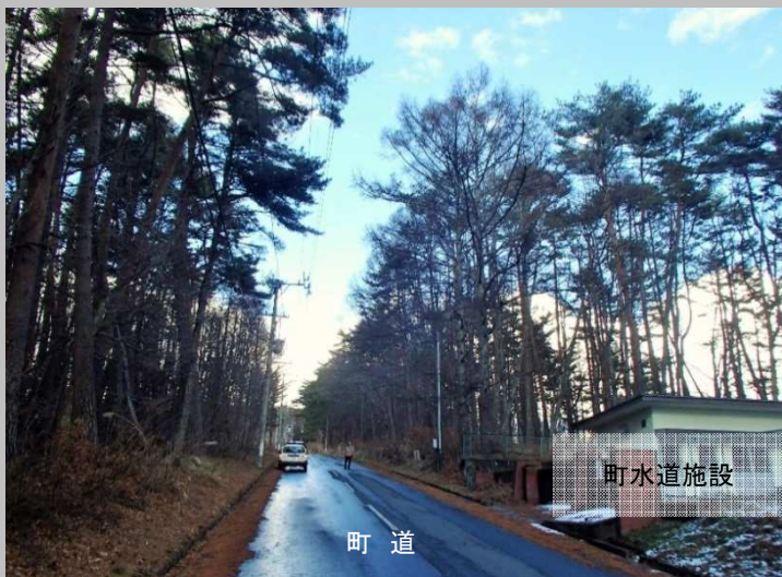
町道沿いに電線が敷設され、倒木により道路の通行、停電及び水道施設に影響を与える危険性が高い
