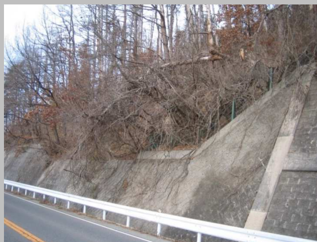
道路沿いの林地で松枯れが拡大しており、強風時や大雨時に国道への倒木が頻繁に発生する。
