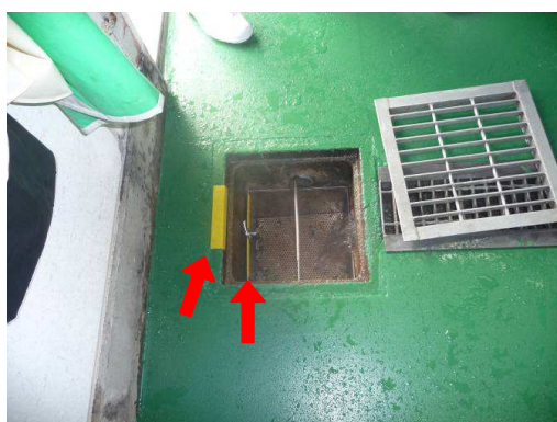
加工室の排水ます (ますと網の黄色のテープを合わせる)
