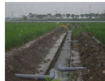
「田んぼダム」実施
