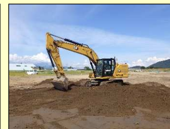
敷均しの様子
