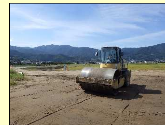
締固めの様子
