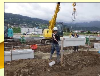
水路設置の様子
