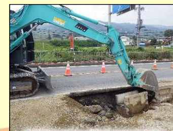
既存水路の撤去
