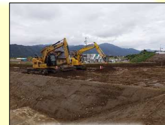
工場内整地の様子
