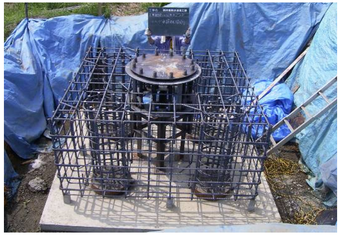
橋脚基礎（鉄筋組立）
