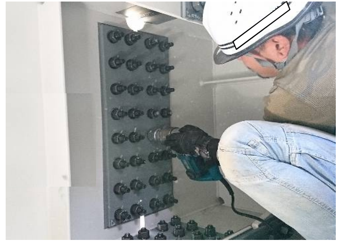
歩道橋架設（ボルト締め）
