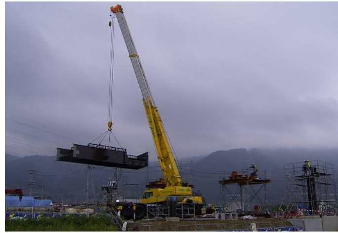
歩道橋架設（通路けた設置）
