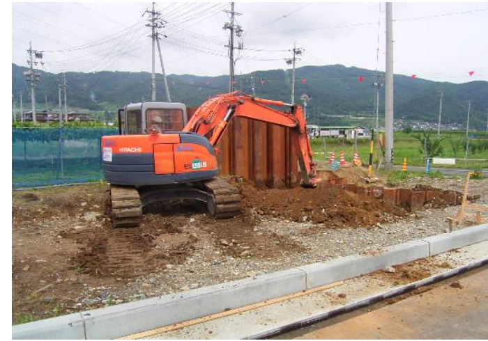
作業土工（掘削）
