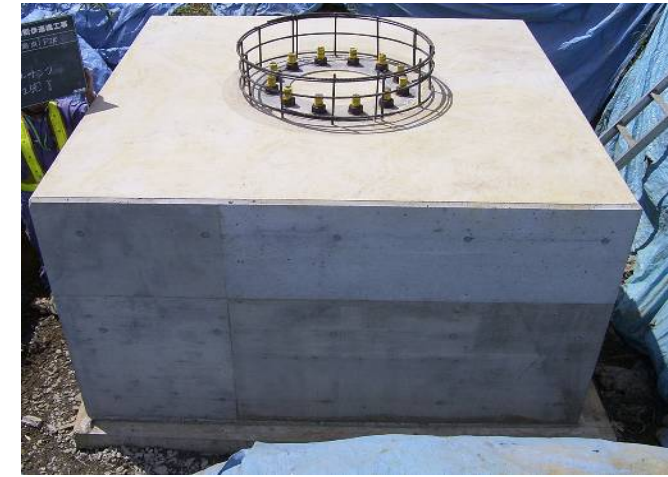
橋脚基礎（コンクリート）
