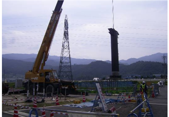
歩道橋架設（橋脚設置）
