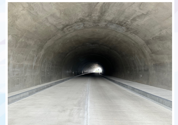
▲（仮称）稲荷山トンネル内の様子
