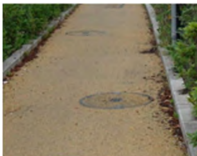
【マンホールの蓋に滑り止め加工している事例】
