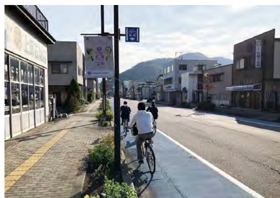
【自転車通行帯の通行状況】
