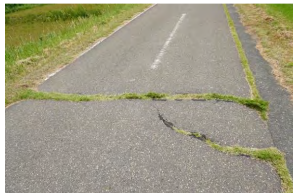
【舗装の劣化状況】
