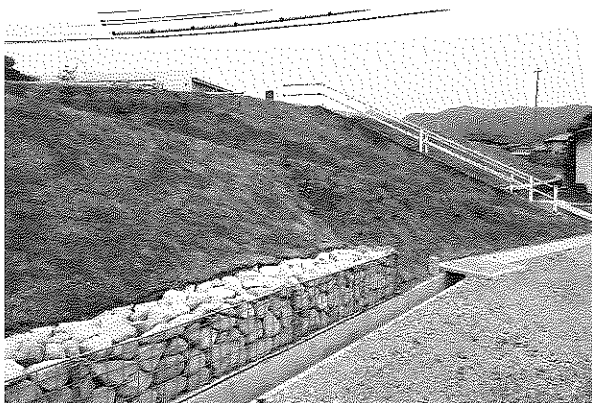
齋場橋 漏水工事完了
