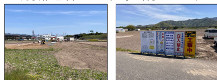
写真③:道路部(市道一重山2号線)両側における用水路・畦畔(けいはん)工事に着手しています
