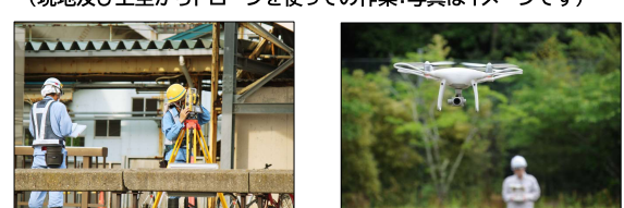
スマートIC本体及び側道等の測量・調査に着手しています(現地及び上空からドローンを使っている作業:写真はイメージです)
