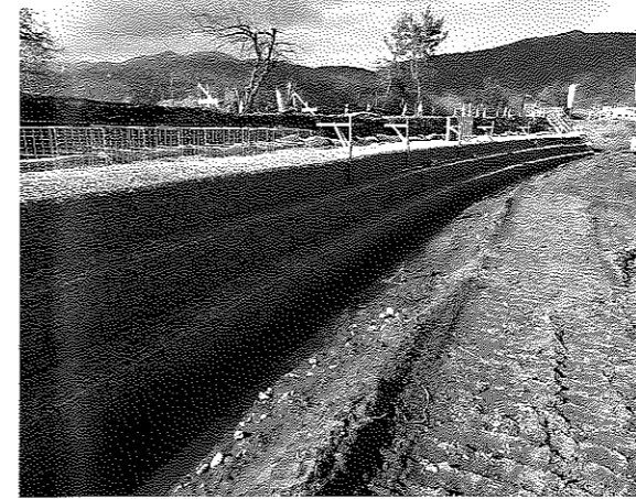
千曲川河川事務所による護岸補修工事の様子
