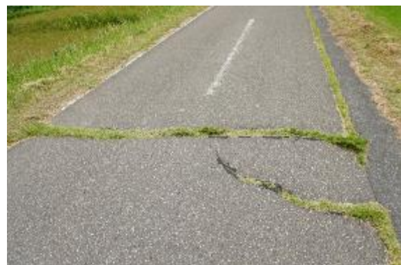
【舗装の劣化状況】
