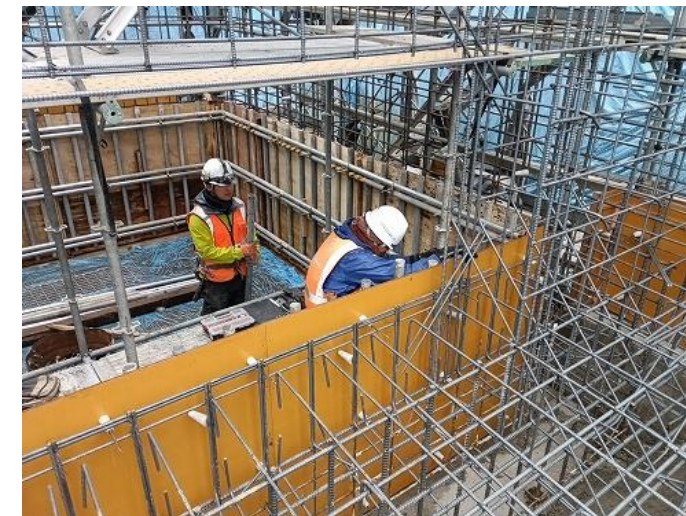
調整池工 型枠組立状況
