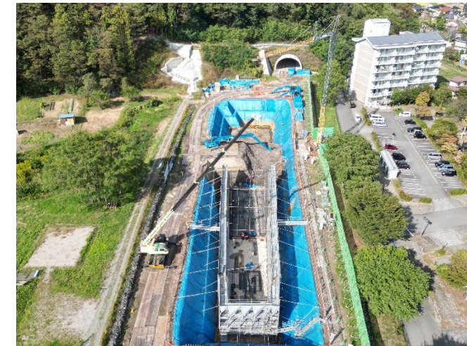
調整池工 ジブクレーン利用状況
