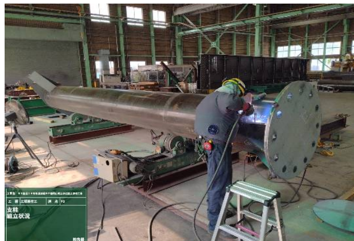
工場製作工 橋脚（支柱）の組立状況
