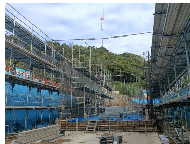
調整池工 足場組立状況
