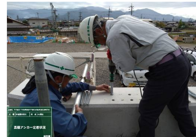
高欄工 高欄アンカーボルト設置
