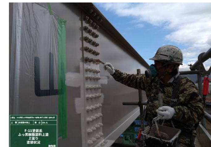
現場塗装工 塗装状況
