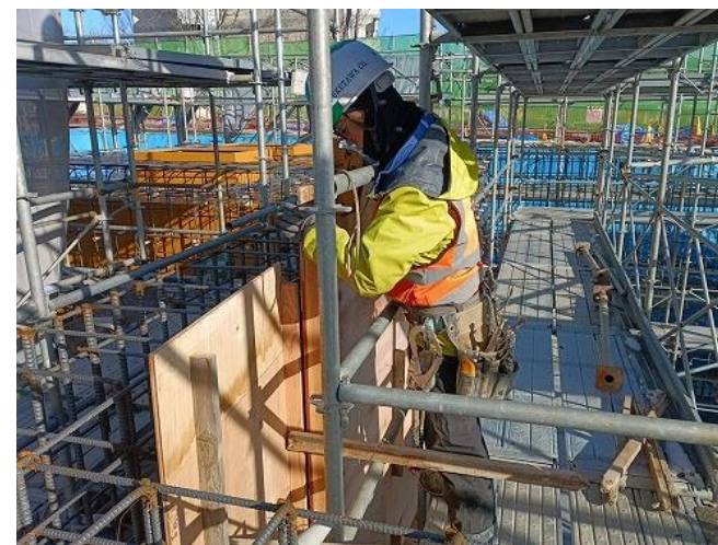
調整池工 型枠設置状況
