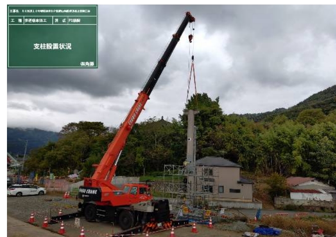
横断歩道橋架設工 橋脚（支柱）架設状況
