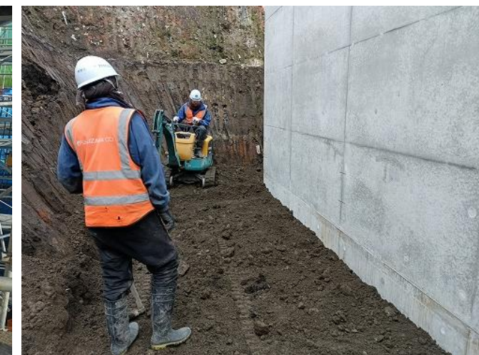
調整池工 埋め戻し状況
