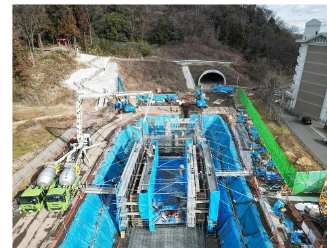
調整池工 側壁打設状況
