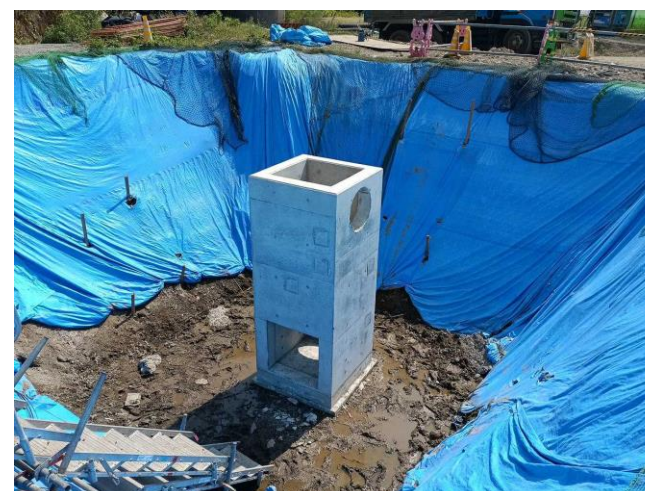
周辺排水構造物（集水桝） 脱型完了
