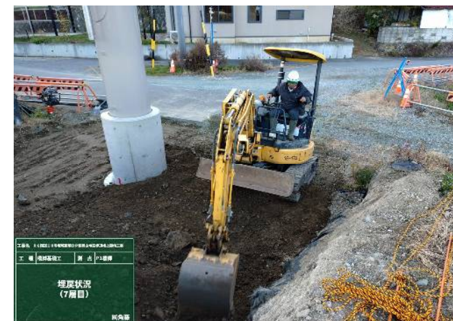
作業土工 埋戻し状況
