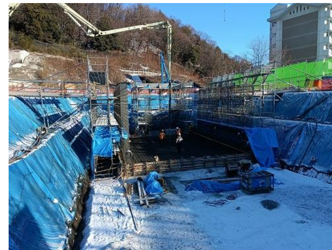
調整池工 底板打設状況
