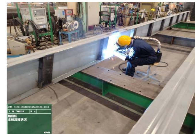
工場製作工 階段けた溶接状況
