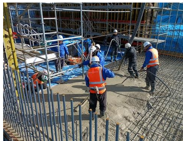
調整池工 底版打設状況
