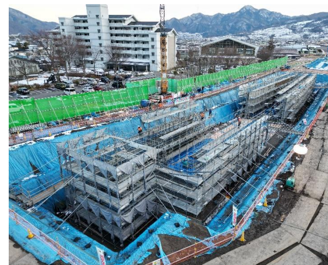
全体施工状況
