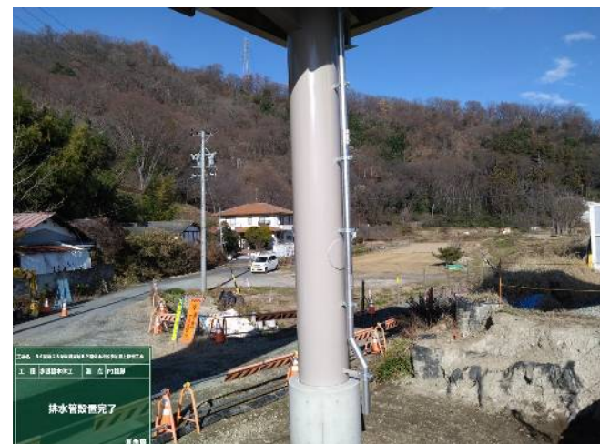
横断歩道橋架設工 排水管設置完了
