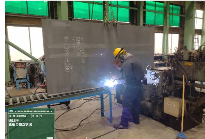
工場製作工 通路桁組立状況
