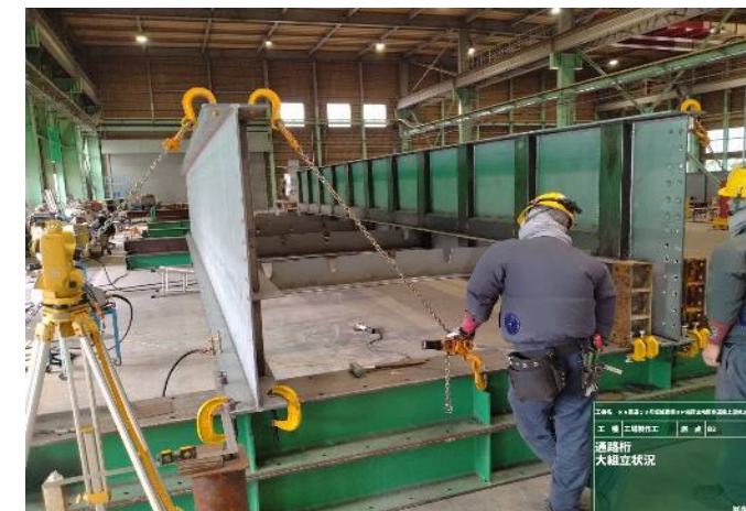
工場製作工 通路けた大組状況
