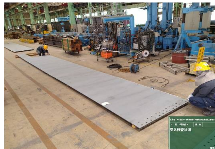
工場製作工 鋼板の受入検査
