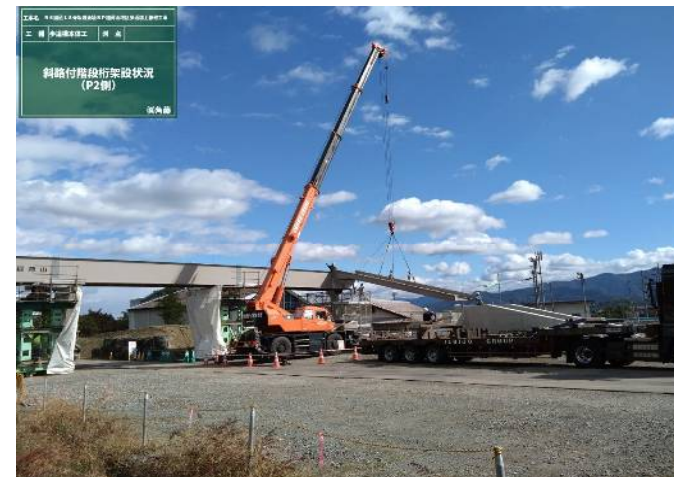
横断歩道橋架設工 階段けた架設状況
