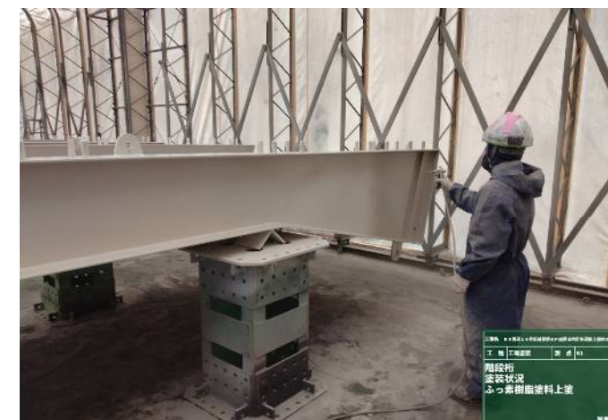
工場塗装工 塗装状況（階段付）
