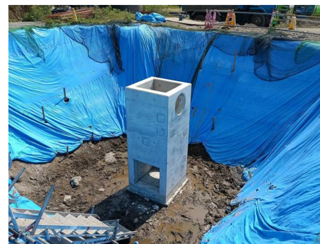
周辺排水構造物（集水桝） 脱型完了
