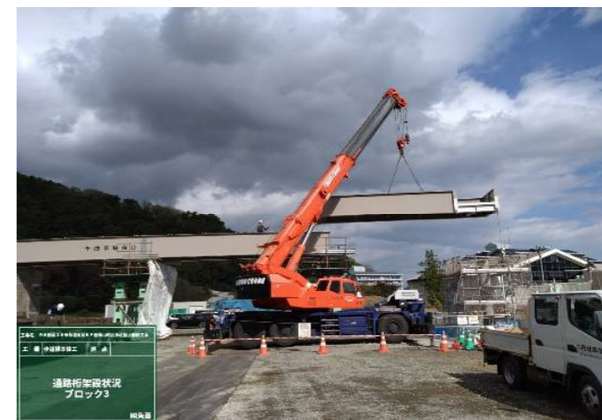
横断歩道橋架設工 通路けた架設状況
