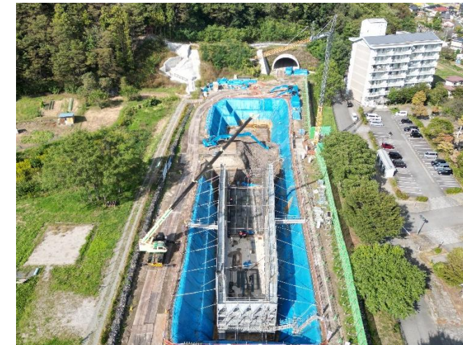
調整池工 ジブクレーン利用状況
