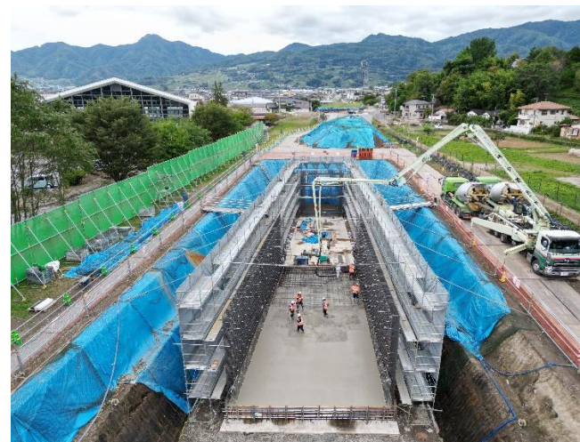
調整池工 底板コンクリート打設状況
