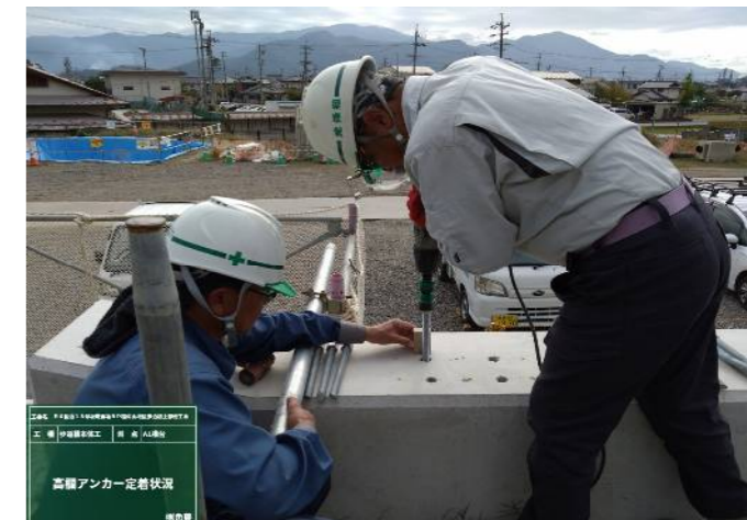
高欄工 高欄アンカーボルト設置
