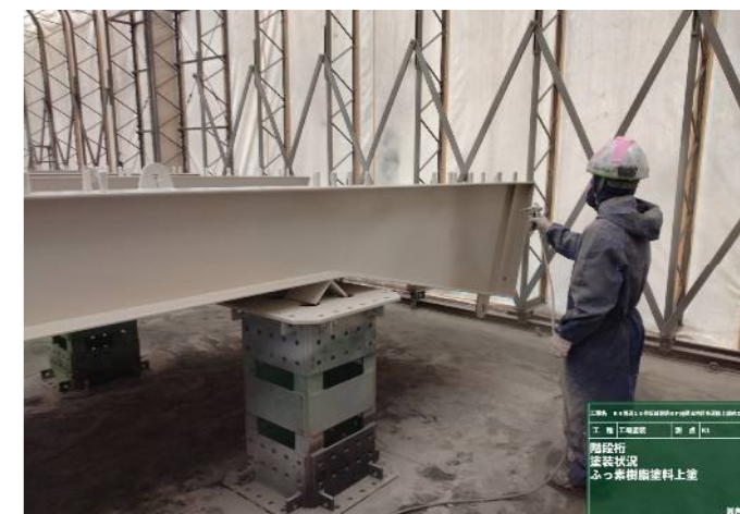
工場塗装工 塗装状況（階段けた）
