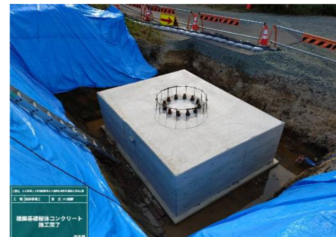
橋脚基礎工 橋脚基礎コンクリート施工完了
