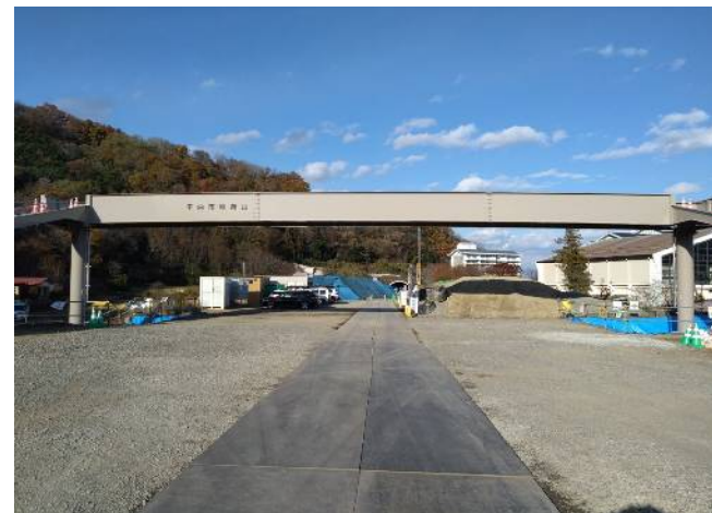
横断歩道橋架設工 ベント設備解体完了
