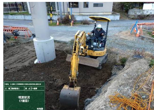
作業土工 埋戻し状況
