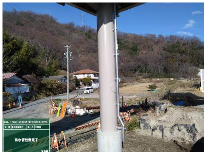
横断歩道橋架設工 排水管設置完了
