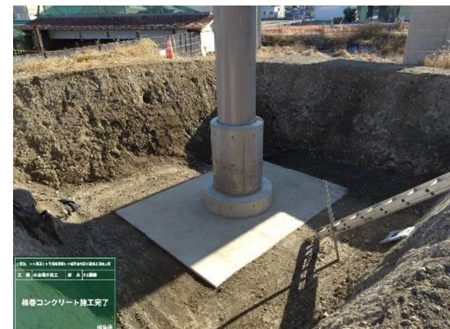
横断歩道橋架設工 根巻コンクリート施工完了
