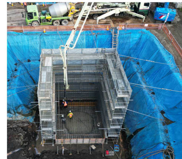
調整池工 コンクリート打設状況
