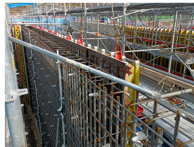
システム型枠 施工状況
