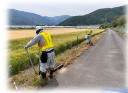
幅杭設置作業状況
