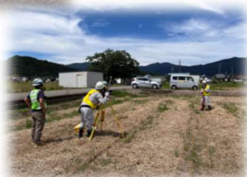
幅杭確認状況
