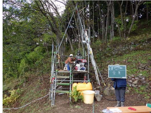
調査状況写真
