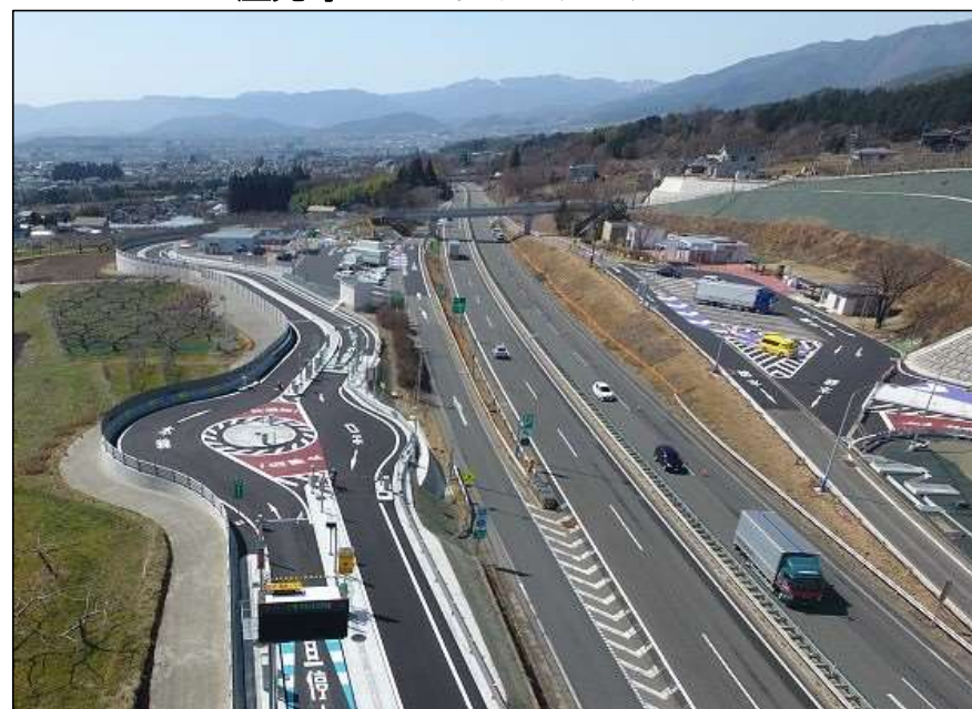
座光寺スマートインターチェンジ
