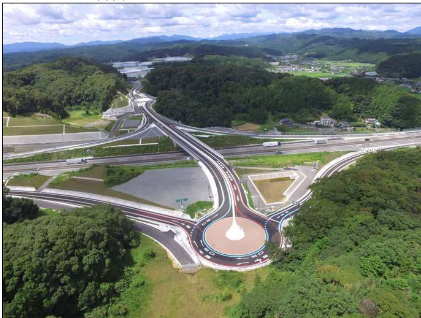
新磐田スマートインターチェンジ
