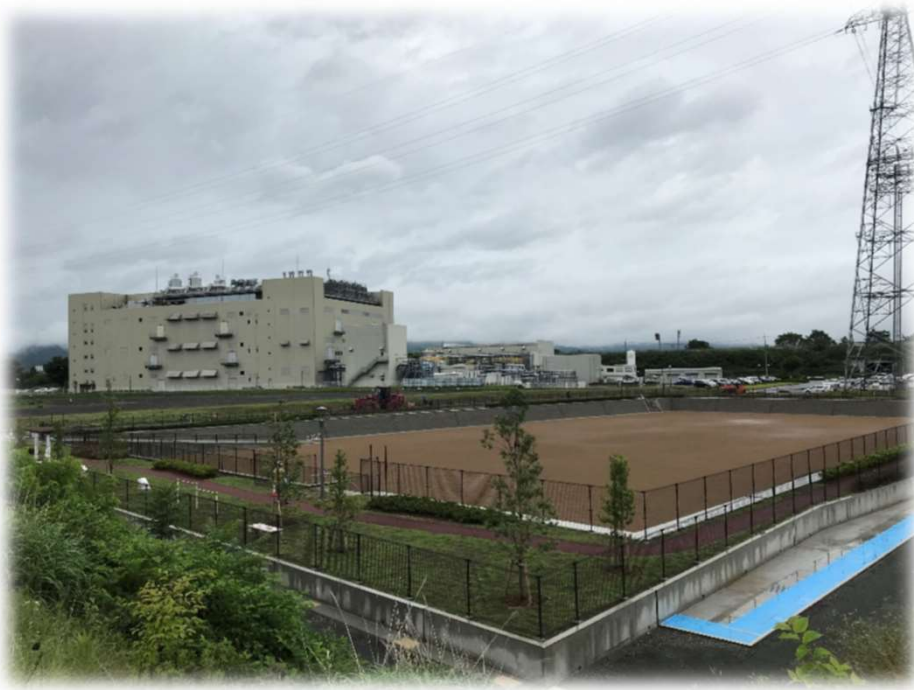
↑【参考】雨宮産業団地における雨水調整池
