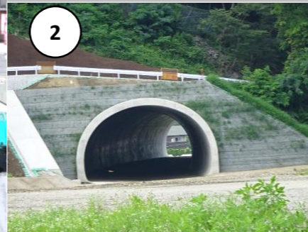
2 貫通した（仮称）稲荷山トンネル
