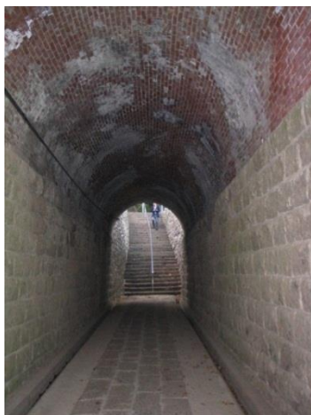
写真 龍洞院架道橋
