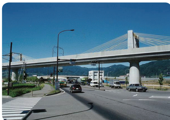
北アルプスの景観に調和した 新幹線屋代南・北橋梁（斜張橋）
