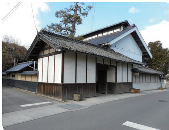
重厚な長屋門、「気抜き」を備えた力石地区の民家
