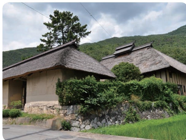
歴史的建造物の瀧澤家住宅
