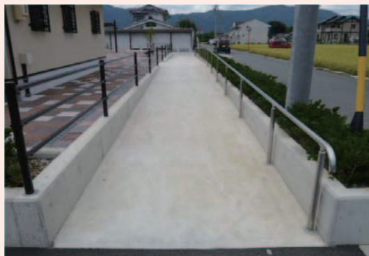
公園出入口にスロープを設置（小舟山公園）
