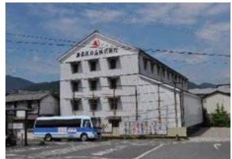
寿高原食品四階倉庫
