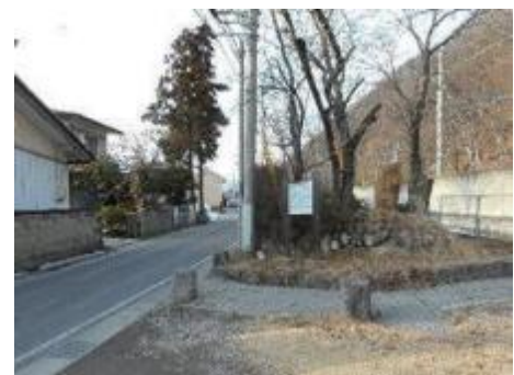
寂蒔水除土堤
