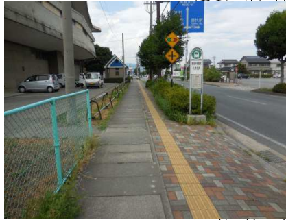
現況写真(西側歩道)
