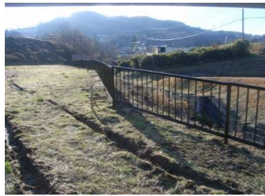
②転落防止柵設置後の状況
