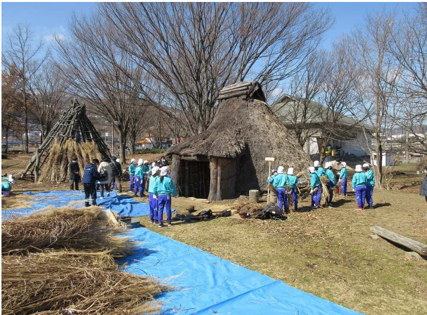
復元住居の差し茅修理(令和4年3月4日実施)
