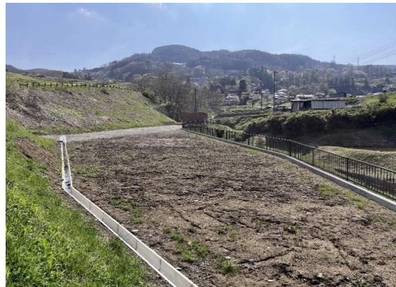
①、②、③整備・設置後の状況
