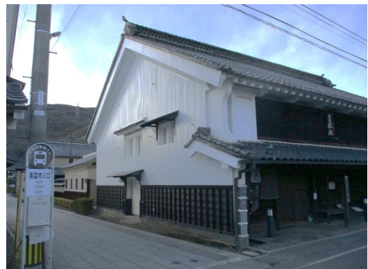
稲荷山宿・蔵し館修理後 R4.12
