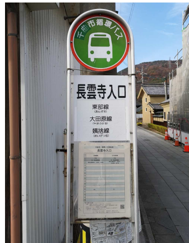
施工前停留所
