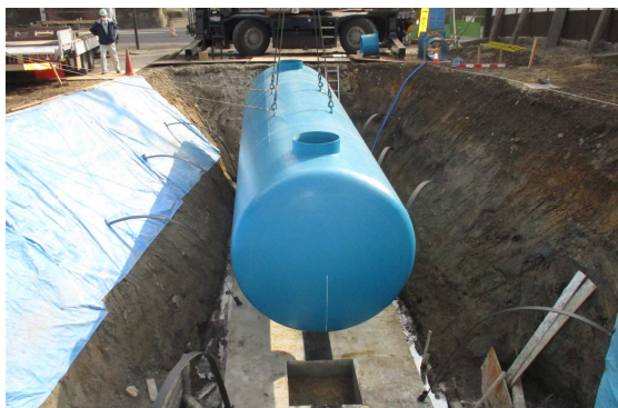
防火水槽施工状況 R5.2
