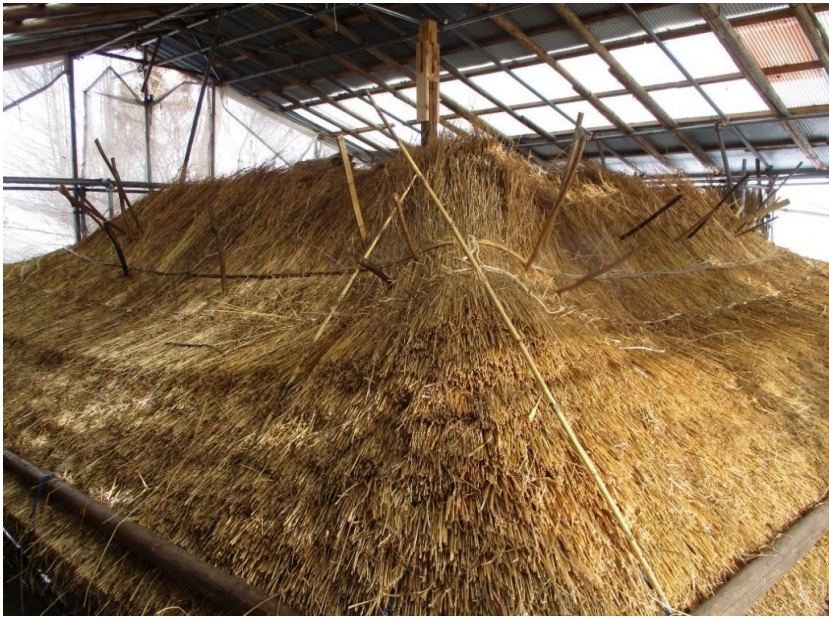
長楽寺月見堂修理工事風景(R7.1)
