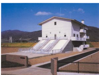
尾米排水 ポンプ場
