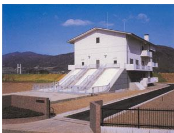
尾米排水 ポンプ場
